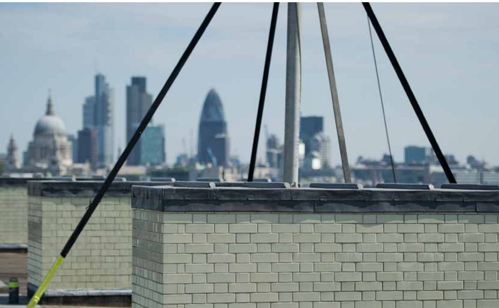
Реставрация с использованием глазурованного кирпича пластического формования под заказ, отель «Савой», Лондон (Великобритания)
