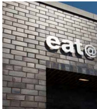
Глазурованный кирпич пластического формования с металлическим эффектом, Стейд Хастинг (Великобритания)
