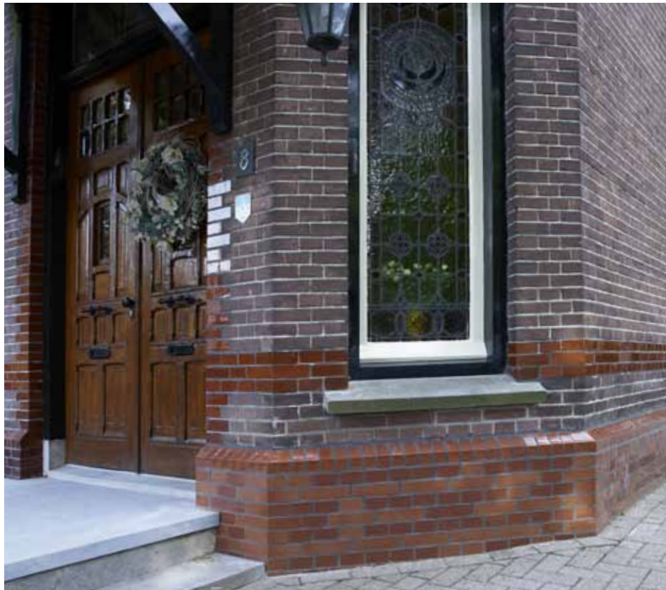
Реставрация с использованием глазурованного кирпича специальной формы
