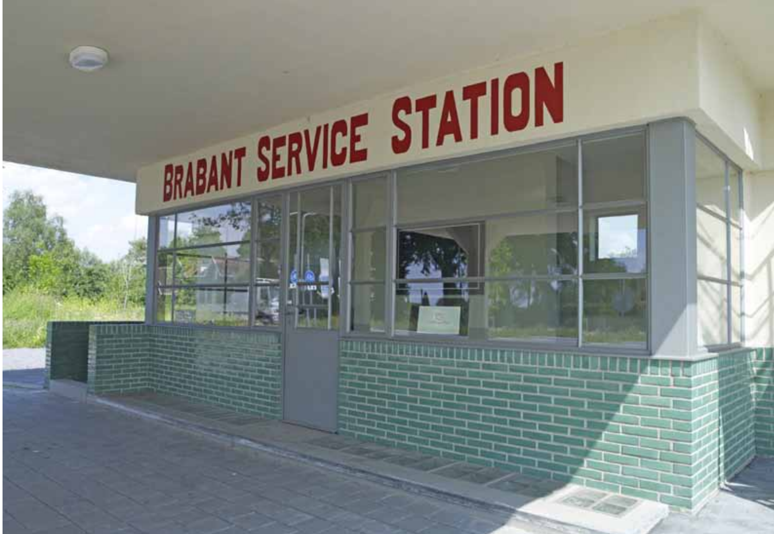
Глазурованный кирпич (ручной формовки vormbak) для проекта реконструкции в стиле новый объективизм, заправка в г. Хертогенбос
