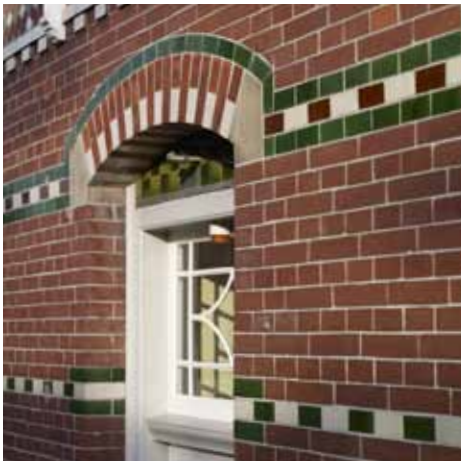
Реставрация с использованием глазурованного фасадного кирпича
